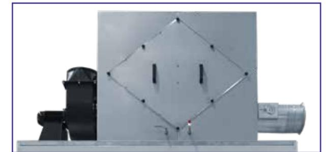
Kreuzstromwärmetauscher zur Energierückgewinnung aus der Ofenabluft
